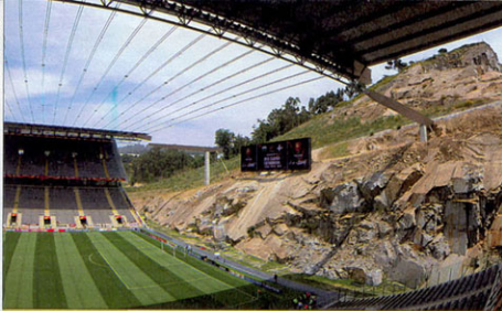
FANTASIA PORTOGHESE Lo stadio municipale di Braga disegnato da Eduardo Souto Moura, che ha ospitato alcune gare di Euro 2004, è stato scavato nella roccia.
